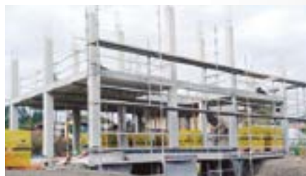
Estructura de Hormigón
