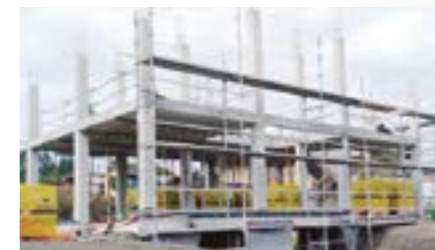
Estructura de Hormigón
